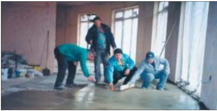
Na oživenie pamäti ešte jeden záber z dostavby KD, o ktorom sme písali v aprílovom čísle. Podkladný betón pod dlažbu vo foyeri pripravujú F. Rybár, M. Estočin a S. Takáč pod dohľadom stavbyvedúceho Hydro-Eko-Stavu Ing. R. Sanislu
