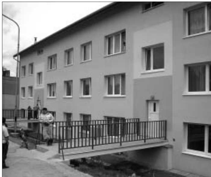
Takto by mala vyzerat' zrekonštruovaná bytovka na Golianovej ulici
