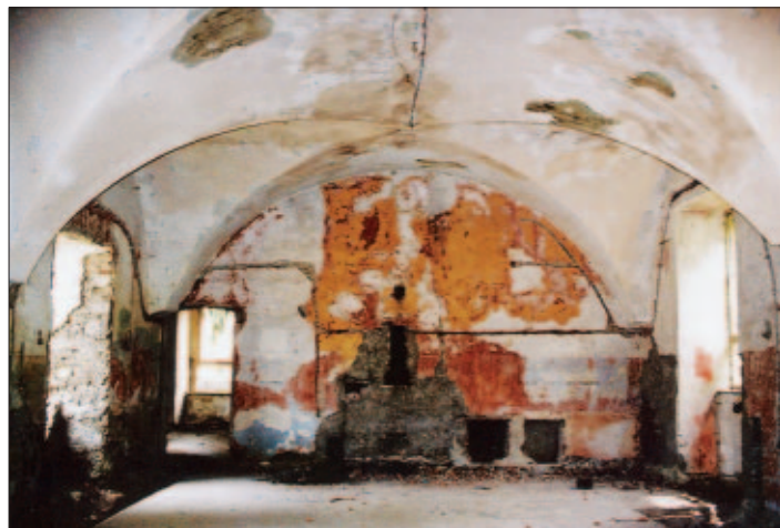
Žiaľ, takto vyzerá v súčasnosti zubom času ohlodaný interiér kaštiela, ktorý čaká na svoju obnovu aj za vašej pomoci. Foto: I. Gojdič
