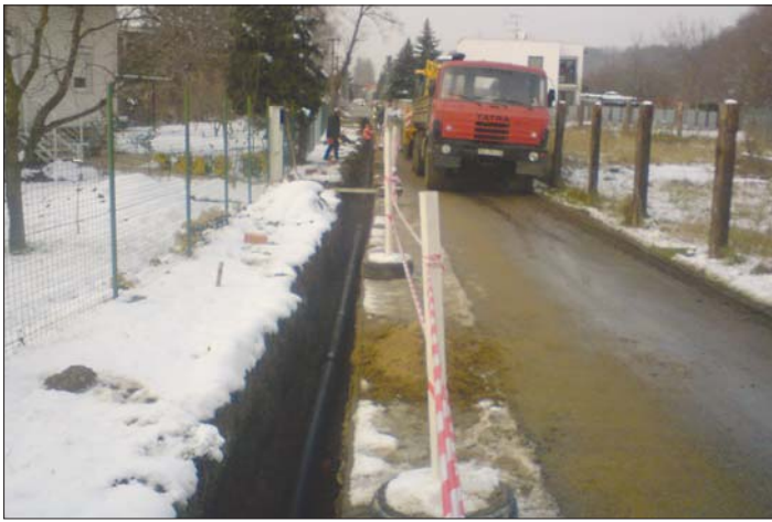
Náš záber je z výstavby tlakovej kanalizácie na ulici „Za mostom“.
