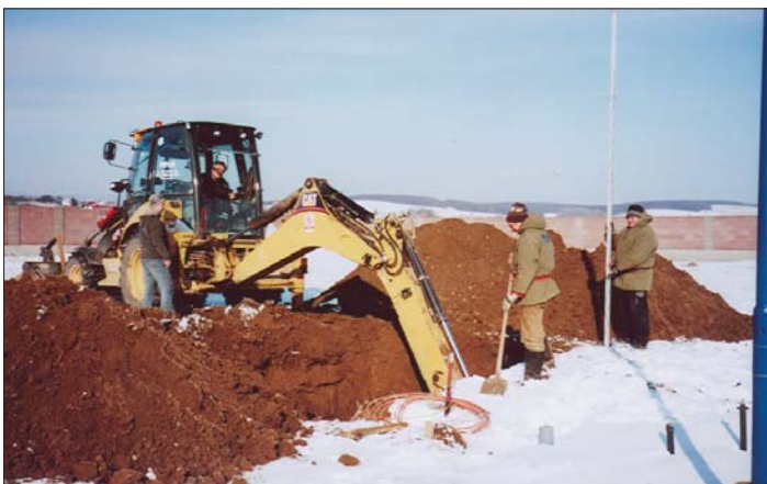
Pri výkopových prácach pre osadenie šácht sme zastihli bagristu J. Karalyoša a tesárov, pomocníkov V. Sýkoru a J. Sciranku pod dohľadom stavbyvedúceho R. Figuru.
