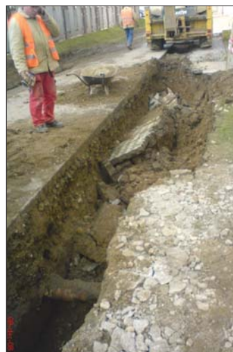
Pri výkope rýhy pre osadenie rúr kanalizácie nastane aj taká situácia, že sa tento zosunie.
