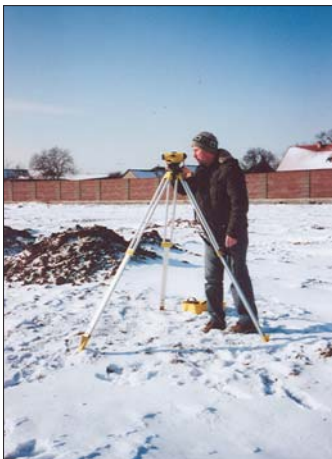
Pri obsluhu nivelizačného prístroja stavbyvedúci Roman Figura na lokalite „Východ“, kde sa kladú „základy“ pre investičnú bytovú výstavbu.
