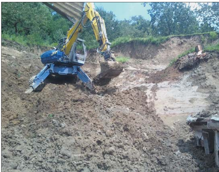
Takto vyzeralo v júni 2010 počas záchranných prác – bagrovania a odvážania zosunutej zeminy pri rodinných domoch P. Vasiľa, F. Topolčanského, P. Berezňáka a M. Berezňákovej na ulici 1 mája. „Kráčajúci báger“ f. Tatry s.r.o. so sídlom v Trstenej pri Hornáde si však poradil s extrémnymi podmienkami na strmom svahu. Foto: Vladimír Gonda
