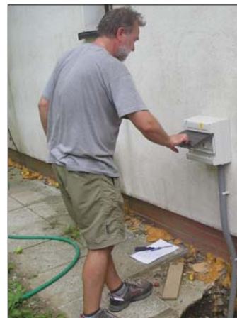
Ing. Peter Hrmo, pri vykonávaní skúšky čerpacej technológie na ulici „Za mostom“.
